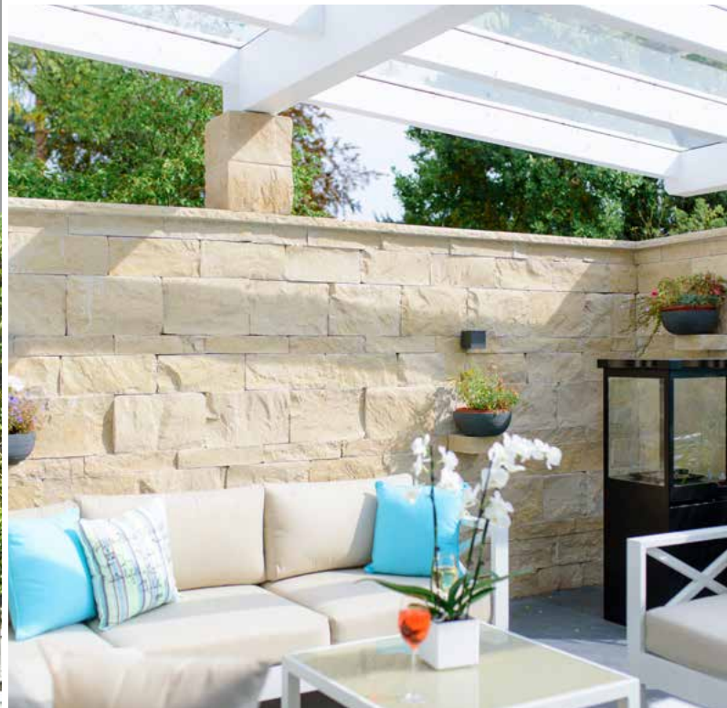
Jura Kalkstein, Schichtmauerwerk
